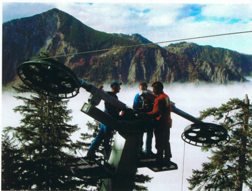
Schwindelfreiheit schadet nicht: Per Hubschrauber werden beim Neubau der Lawinensprengbahn am Spitzing die Teile der insgesamt elf Stützen herangeschafft. Dann ist in steilem Gelände und luftiger Höhe Handarbeit angesagt.
